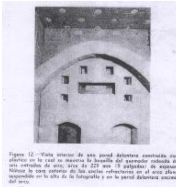
Figura 12.—Vista interior de una pared delantera construida con plástico en la cual se muestra la boquilla del quemador rodeada de seis entornos de aire; arco de 229 mm (9 pulgadas) de espesor. Nótese la cara exterior de las solas refractarias en el arco plana suspendida en la alta de la fotografía y en la pared delantera encima del arco.
